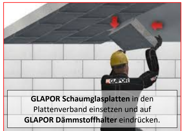
GLAPOR Dämmstoffhalter in GLAPOR Schaumglasplatten eindrücken und mit zugelassenen Dübeln mechanisch fixieren.
