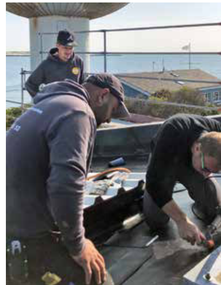
Bild links: AWI auf Helgoland – Weiß hervorgehoben, die zu sanierende Flachdachfläche. Bild rechts: Der GLAPOR Baustellenservice unterstützt Architekten und Verleger beim regelkonformen Einbau der Schaumglasplatten und steht mit Rat und Tat zur Seite - so können die hohen Qualitätsanforderungen mit GLAPOR Unterstützung umgesetzt werden.
