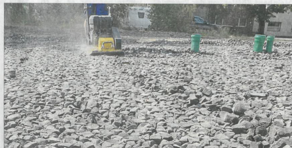
Schaumglas-Schotter ist zu 100 Prozent aus Altglas produziert. Das macht die Dämmmaterialien von Glapor besonders nachhaltig. Bild: Firma Glapor Mitterteich/exb
