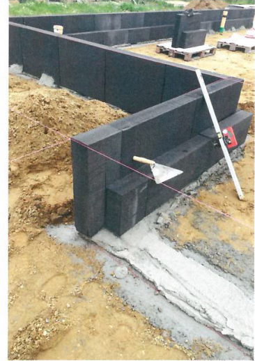
3 + 4 Beim verwendeten Glapor RDS-System fassen Schalungselemente aus Schaumglasplatten die lose Schüttung aus Schaumglasschotter sauber ein, die verwendeten RDS-Elemente bilden dabei die Gussform für die Bodenplatte aus Beton – eine weitere Schalung oder Abspreizung wird nicht benötigt. Fotos 3 + 4: Glapor
