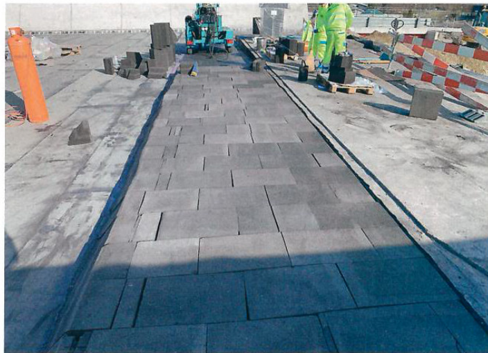
Perimeterdämmung mit GLAPOR Schaumglasplatten im Baukastensystem Foto] GLAPOR
