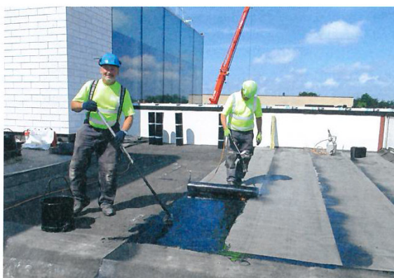
▲ Moderner Flachdachaufbau: Verlegung einer Bitumenabdichtung auf der Schaumglasdämmung
