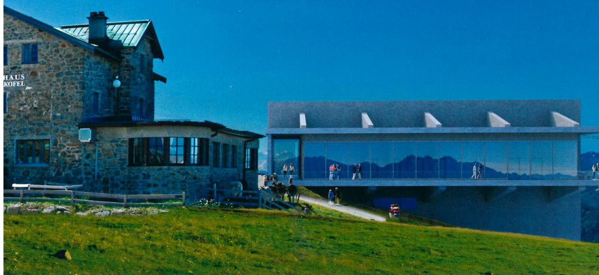
Baustelle in 1.965 m Höhe – die neue Bergstation der Patscherkofelbahn.
