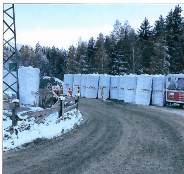
In 1,5 m 3 Big Bags stehen 325 m 3 Glapor Schaumglasschotter auf der Baustelle bereit.
