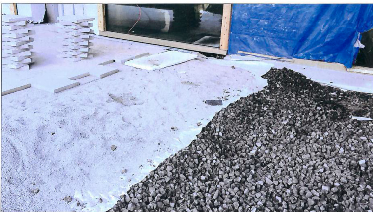
Schaumglasschotter: Ein Leichtgewicht, einfach und schnell im Einbau.
