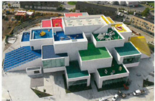
Mit Schaumglasplatten wurden die Flachdächer des Lego-Hauses gedämmt.
