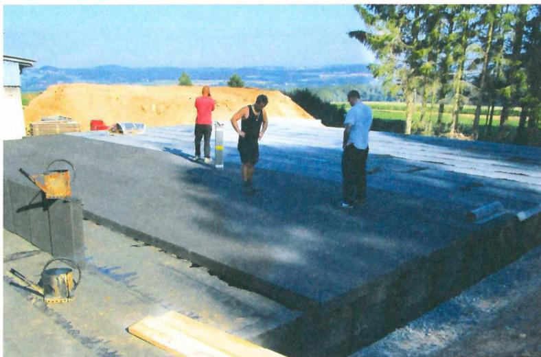
Die aus Altglas hergestellten Schaumglasplatten wurden sowohl im Perimeterbereich für die vertikale Dämmung als auch vor der Überschüttung für die klassische Abdichtung nach oben verwendet. | Fotos: Glapor
