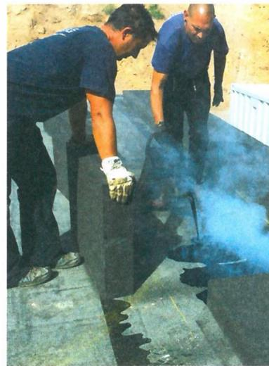
Die Dämmplatten werden mit Heißbitumen vollflächig im Verband durch diagonales Einschleiben auf dem Untergrund verklebt.
