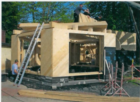
Der Pavillon wurde mit einer Schaumglasschottergründung unter der Bodenplatte realisiert.
