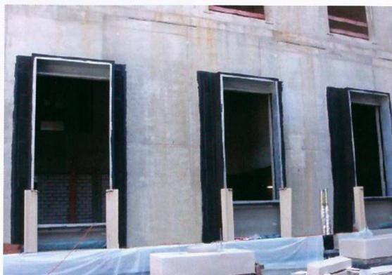
Außergewöhnliche Anforderungen bedürfen besonderer Lösungen. Bei der Planung des Berliner Humboldtforums stieß das Unternehmen Bilfinger Fassadentechnik GmbH auf eine ebendieser Herausforderungen. Für den Betonbau mit vorgesetzter Natursteinfassade benötigten die Fassadenbauer ein Dämmmaterial für den passenden Übergang zwischen den Stahlzargen der bodentiefen Fenster und der Vorsatzfassade.
