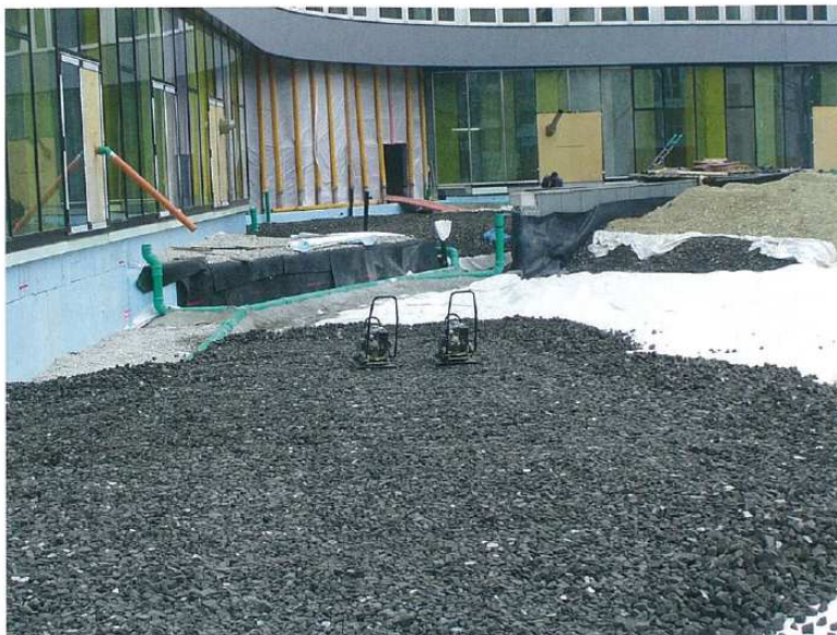
Rund 2.000 Kubikmeter Glasschaumschotter sorgten bei dem ADAC als Leichtschüttung für eine gelungene architektonische Gestaltung auf dem Flachdach der Tiefgarage.
