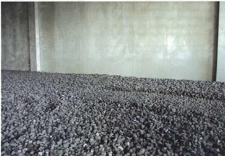
Für die Dämmung: Schaumglasschotter
