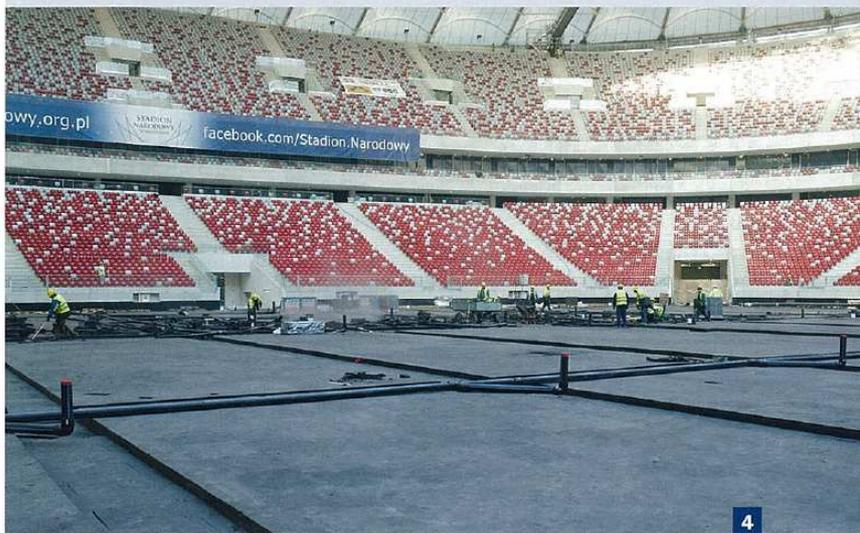
**3** Bis zu 3 Lagen der form- und volumenbeständigen Platten wurden eingebaut, so dass die Schicht zwischen 50 und maximal 300 mm hoch ist. Insgesamt wurden in der neuen Luxusarena 3.300 m<sup>3</sup> bzw. 15.000 m<sup>2</sup> dieser Dämmplatten verlegt und rund 60 t des Bitumenklebers verarbeitet.
