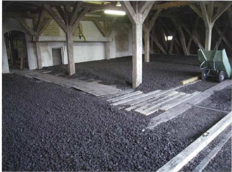
Provisorische Laufstege auf der Schüttung zum Verteilen mit Teerschieber
