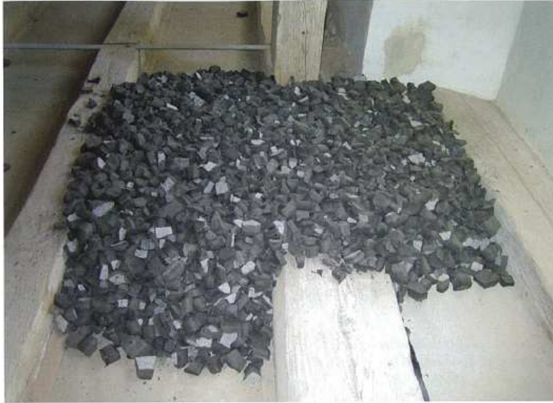
Beginn der Schüttung in variabler Höhe
