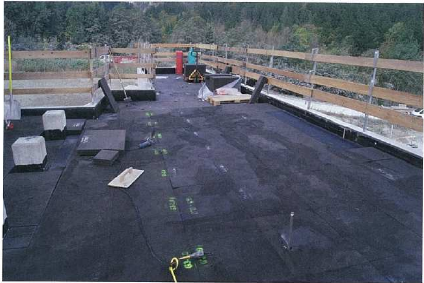
Verlegung der Schaumglasplatten am Bosrucktunnel
