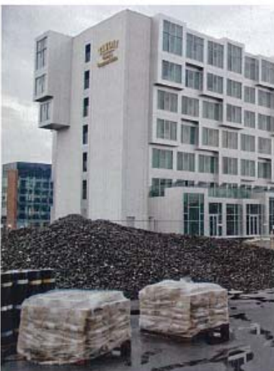
Der Glasschaumschotter vor dem Einbau. | Fotos: Glapor
