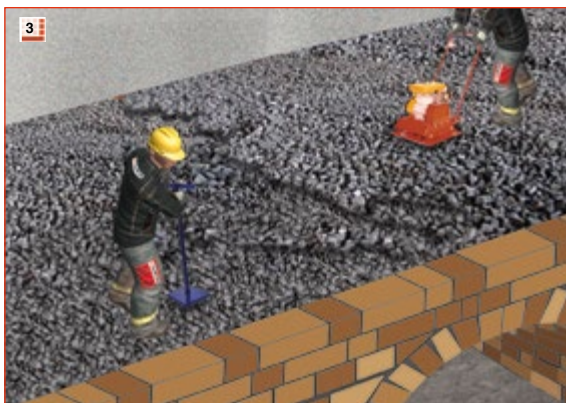
3 GLAPOR Schaumglasschotter verteilen und vorsichtig verdichten. Gegebenenfalls erfolgt die Verdichtung mit einem Handstampfer.
