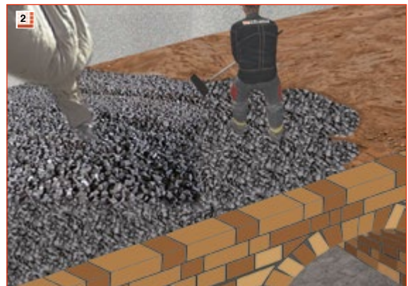
2 GLAPOR Schaumglasschotter mit einer 30 % Überhöhung einbauen. HINWEIS: Die Gewölbedecke muss statisch überprüft werden, ob die Belastung aus der Verdichtung aufgenommen werden kann.
