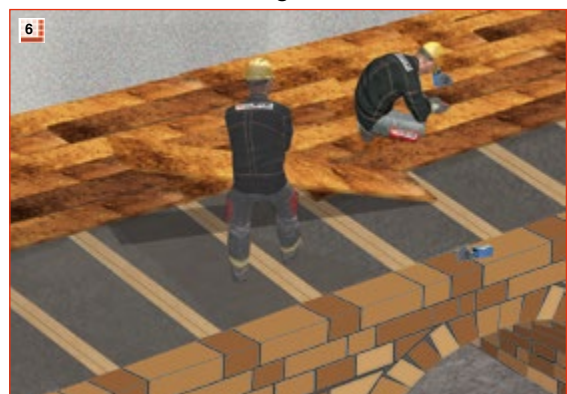
6 Holzfußboden durch verschrauben mit der Konterlattung verlegen. Auf die Verwendung von Nägeln sollte verzichtet werden.
