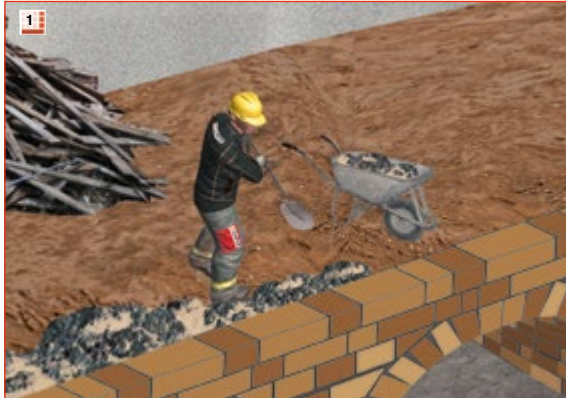
1 Alte Fußbodenkonstruktion demontieren und Schüttmaterial entfernen.
