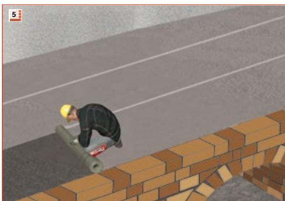
**5** Oberhalb der Sauberkeitsschicht wird eine Trenn- und Gleitfolie aus einer PE Folie verlegt.
