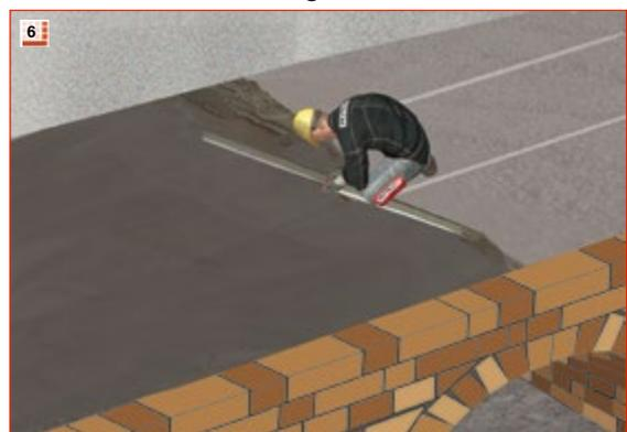
**6** Zementestrich auf der Trenn- und Gleitfolie einbauen. Weitere Estrichvarianten sind möglich, Kontaktieren Sie bitte dazu unsere Anwendungstechnik.
