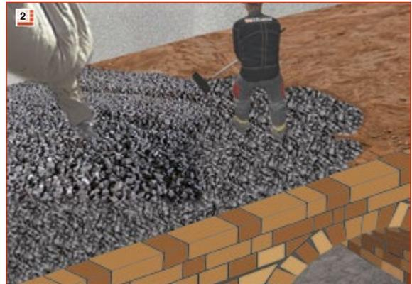
**2** GLAPOR Schaumglasschotter mit einer 30 % Überhöhung einbauen.
