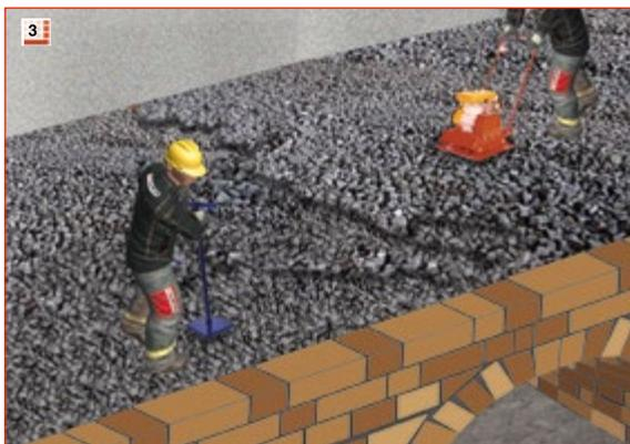
**3** GLAPOR Schaumglasschotter verteilen und vorsichtig verdichten. Gegebenenfalls erfolgt die Verdichtung mit einem Handstamper.
