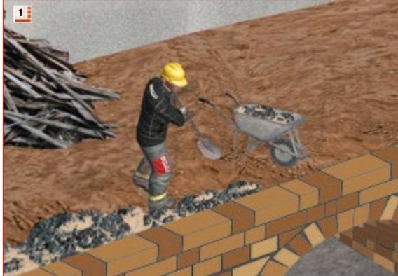
**1** Alte Fußbodenkonstruktion demontieren und Schüttmaterial entfernen.
