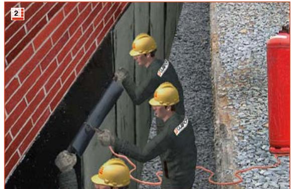
**2** Bitumenschweißbahnen mit einem Brenner
